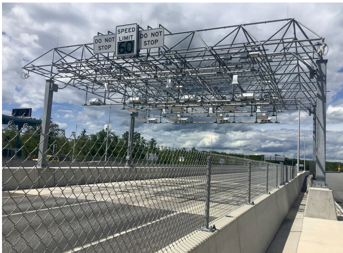
WEST GARDINER BARRIER TOLL PLAZA ORT LANE
